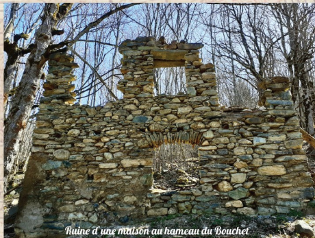
Ruine d'une maison au hameau du Bouchet
