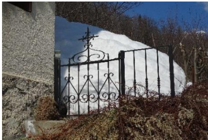
Portail de fer forgé et façade d'enduit taloché brut - Balcon de fer forgé repeint de gris et façade en enduit blanc
