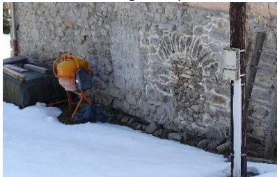
Soubassement en pierre de taille et ancienne ouverture bouchée. - Chaînage d'angle en pierre de taille et enduit de teinte rose pâle
