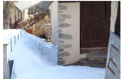
Soubassement en pierre de taille et ancienne ouverture bouchée. - Chaînage d'angle en pierre de taille et enduit de teinte rose pâle
