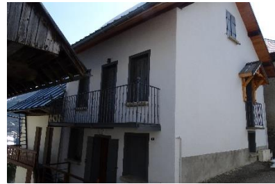
Portail de fer forgé et façade d'enduit taloché brut - Balcon de fer forgé repeint de gris et façade en enduit blanc
